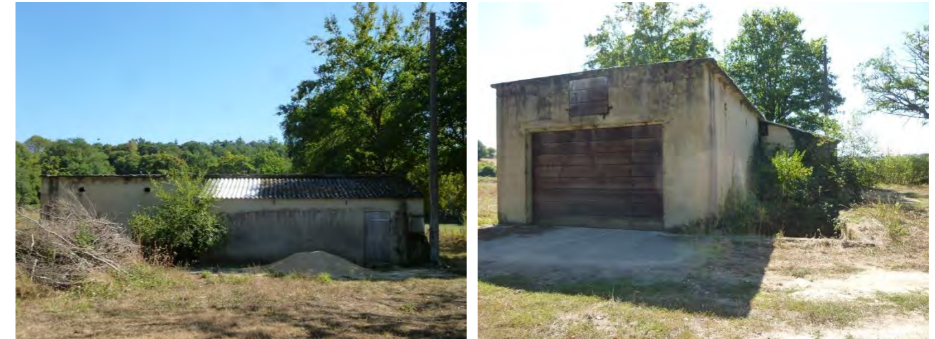
Photographie 17 : Bâtiment agricole recensé sur la ZIP (source : ENCIS Environnement)
