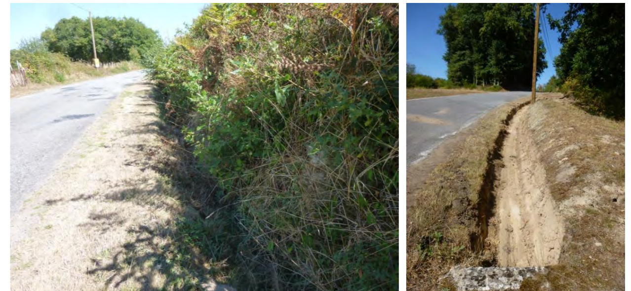
Photographie 9 : Fossés recensés sur la ZIP (source : ENCIS Environnement)
